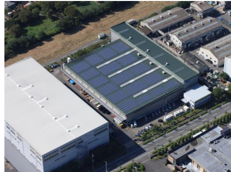
屋根部分にとりつけられたソーラーパネル (大利根工場の航空写真)
